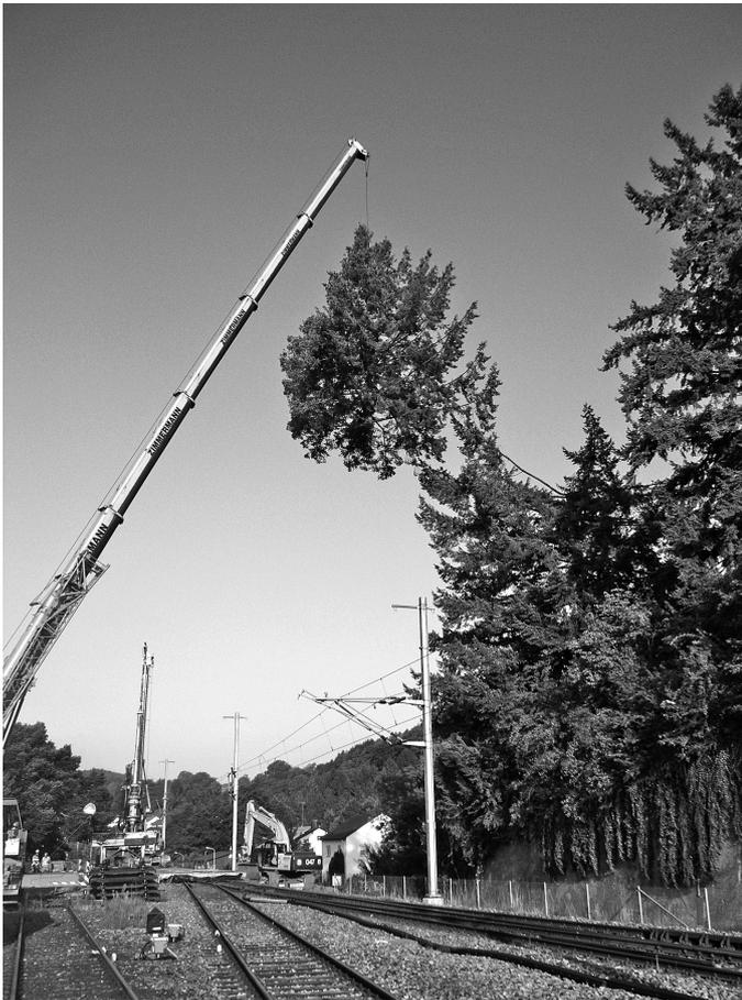
Mit einem 80 Tonnenkran wurden die Teilstücke über die Gleisanlagen gehoben.
