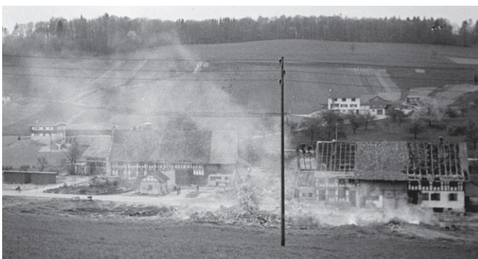
Abbruch von Solgen 1966
